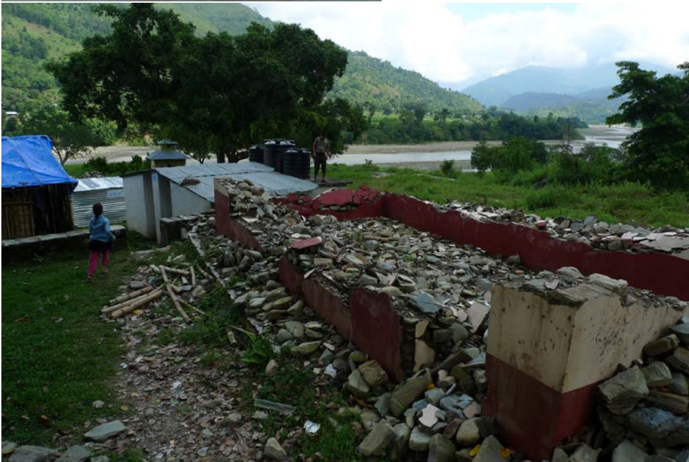
Figure 6 Schulbibliothek/Lehrerzimmer "in rubbles", Sept. 2015
